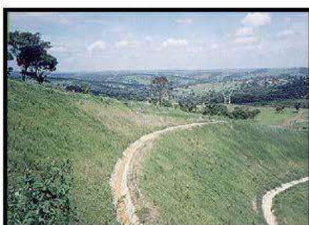
Foto 12 - Resultado do trabalho, mostrando toda a área protegida, o estabelecimento da vegetação e a ausência de sulcos e focos erosivos.
